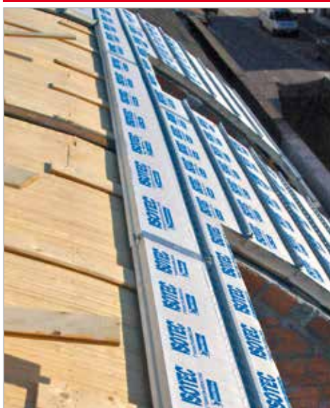
Posa di Isotec su struttura continua in legno.
