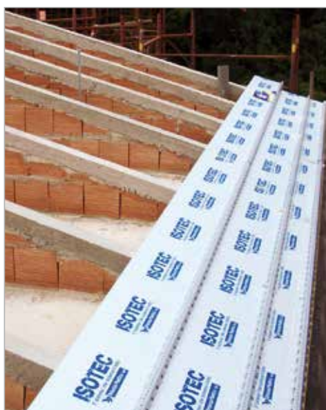
Posa di Isotec su struttura discontinua su muretti.
