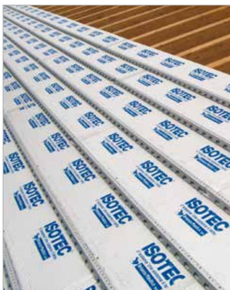
Posa di Isotec su struttura discontinua in legno.
