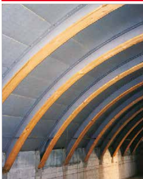
Posa di Isotec su struttura discontinua a volta.
