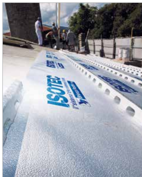
Posa di Isotec su struttura continua in laterocemento.
